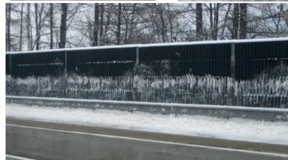
Instalováno v roce 2008: Stěna Calma-Tec LB-C na A10 v Lendorfu (Rakousko)
