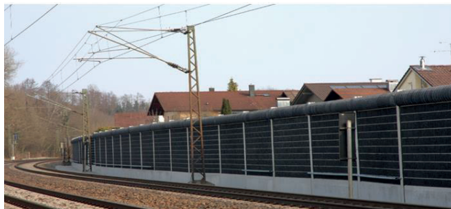
Zkušební dráha Deutsche Bahn Rosenheim instalovaná v roce 2011
